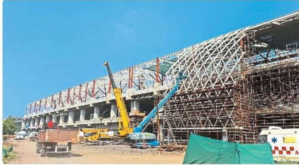
सूरत बुलेट ट्रेन स्टेशन के आगे का हिस्सा डायमंड में ले रहा आकार।
